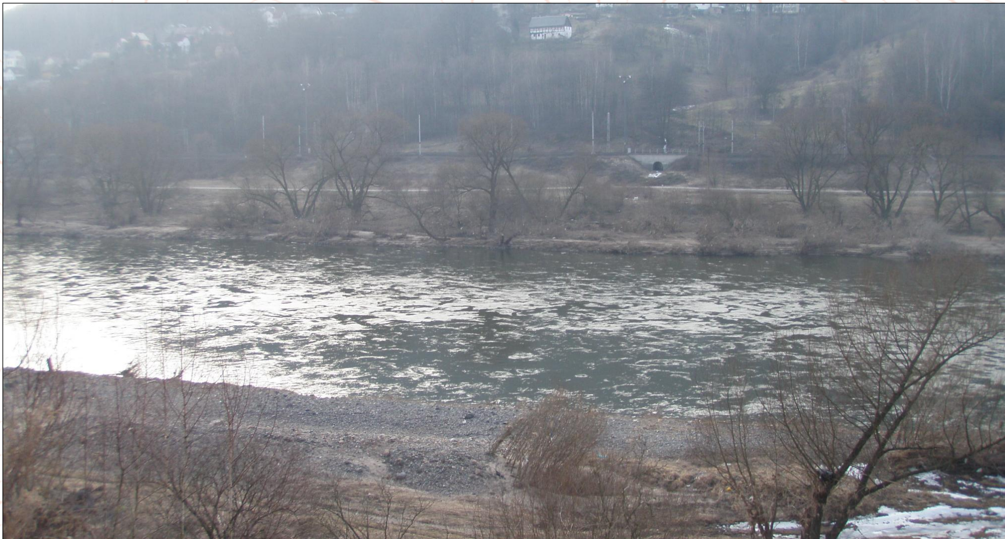
Charakter území v místě plavebního stupně - deponie štěrků z prohrábek, řečiště a zarostlý levý břeh
